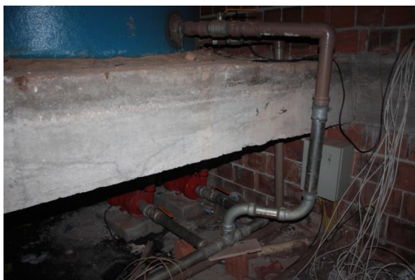
Reservatório superior do Bloco A
