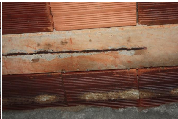
Reservatório inferior do Bloco B
