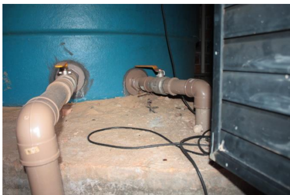
Reservatório superior do Bloco A
