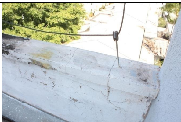
Cobertura do Bloco B
