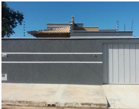
Figura 5 - Acabamento padrão normal - fachada.
