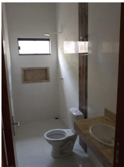
Figura 7 - Acabamento padrão normal - banheiro.
