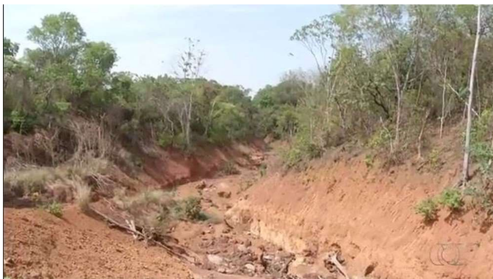
Figura 1 – Voçoroca formada no Parque Cesamar, Palmas – TO.
