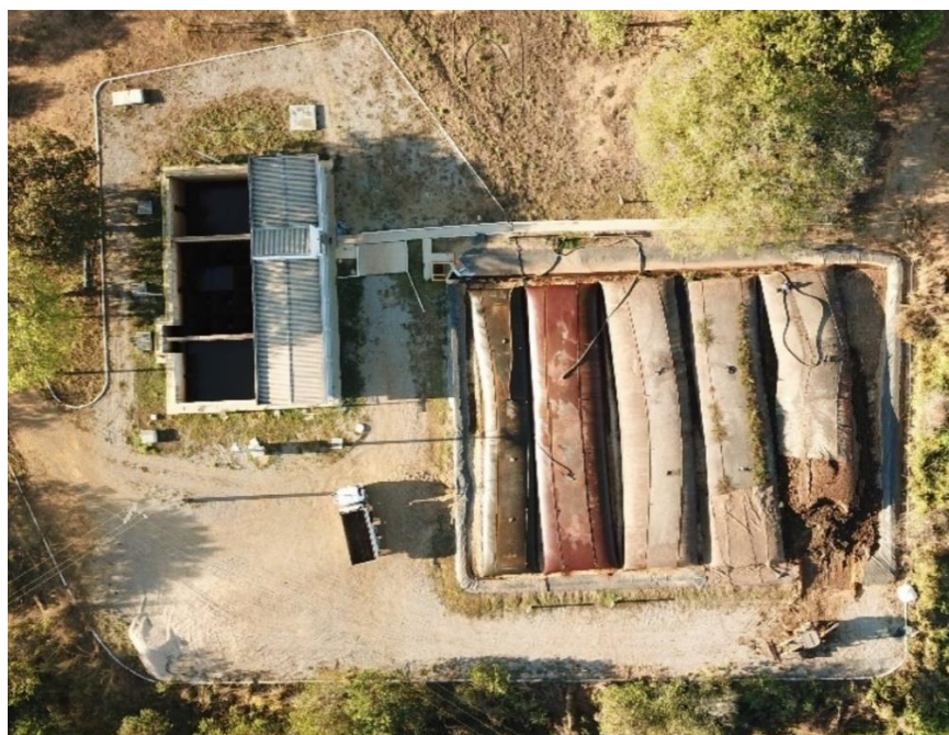
Figura 4.4 - Foto aérea da ETR da ETA 006 em Palmas - TO
