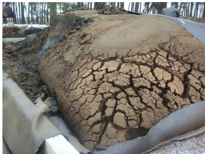
Figura 2.3 - Bag de tecido geotêxtil em fim de operação com resíduo desaguado
