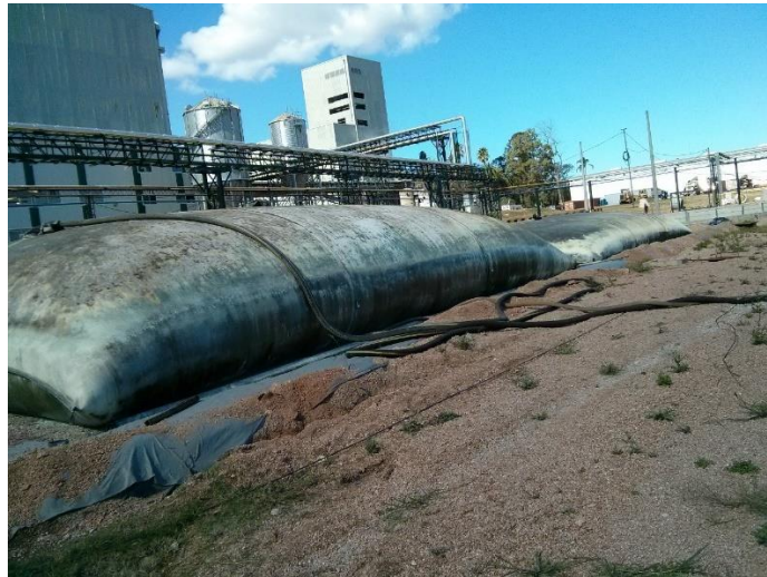
Figura 2.2 - Bag de tecido geotêxtil em operação
