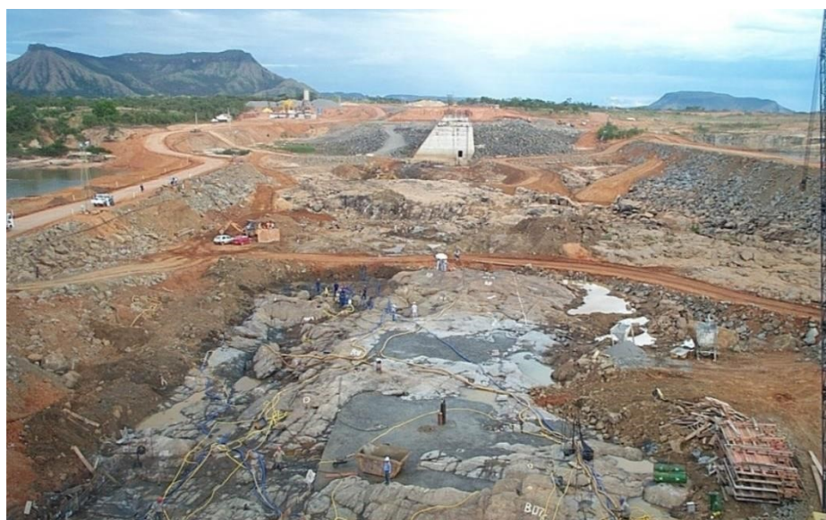
Figura 7. Preparação da fundação na UHE Lajeado
