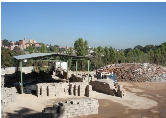
Figura 3. Unidade de processamento de bloco produzidos com RCC
