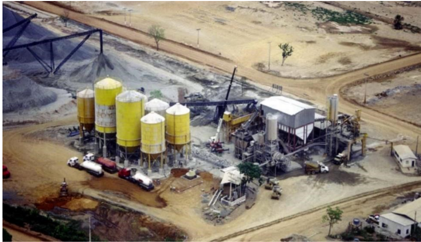
Figura 6. Central de concreto da UHE Lajeado
