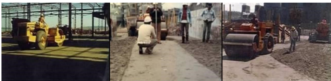
Figura 4. Primeira utilização de CCR na usina de Itaipu
