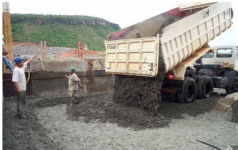
Figura 10. Lançamento de CCR
