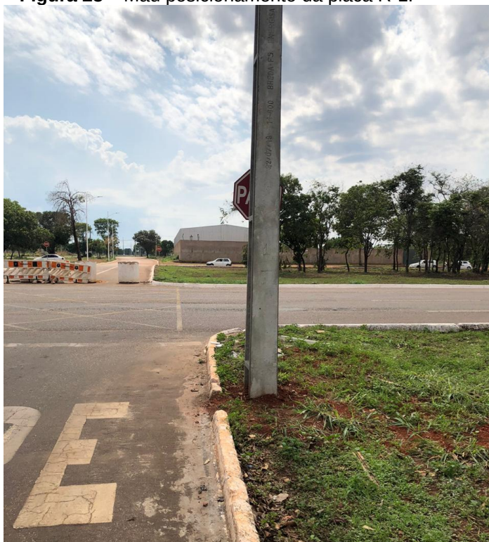
Figura 23 – Mau posicionamento da placa R-1.
