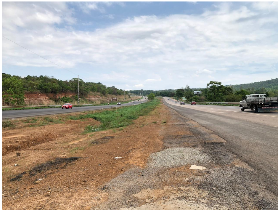
Figura 17 – BR-010 nas mediações da entrada da Faculdade Católica Campus II (km 05). Sentido Sul/Norte
