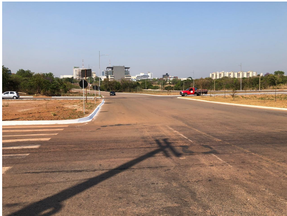
Figura 13 – Cruzamento das Avenidas LO-08 e Joaquim Teotônio Segurado. Sentido Sul/Norte.
