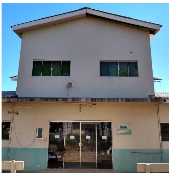
Figura 78 – Vista frontal do bloco da UMA
