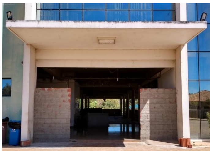
Figura 67 – Vista frontal da Biblioteca Central
