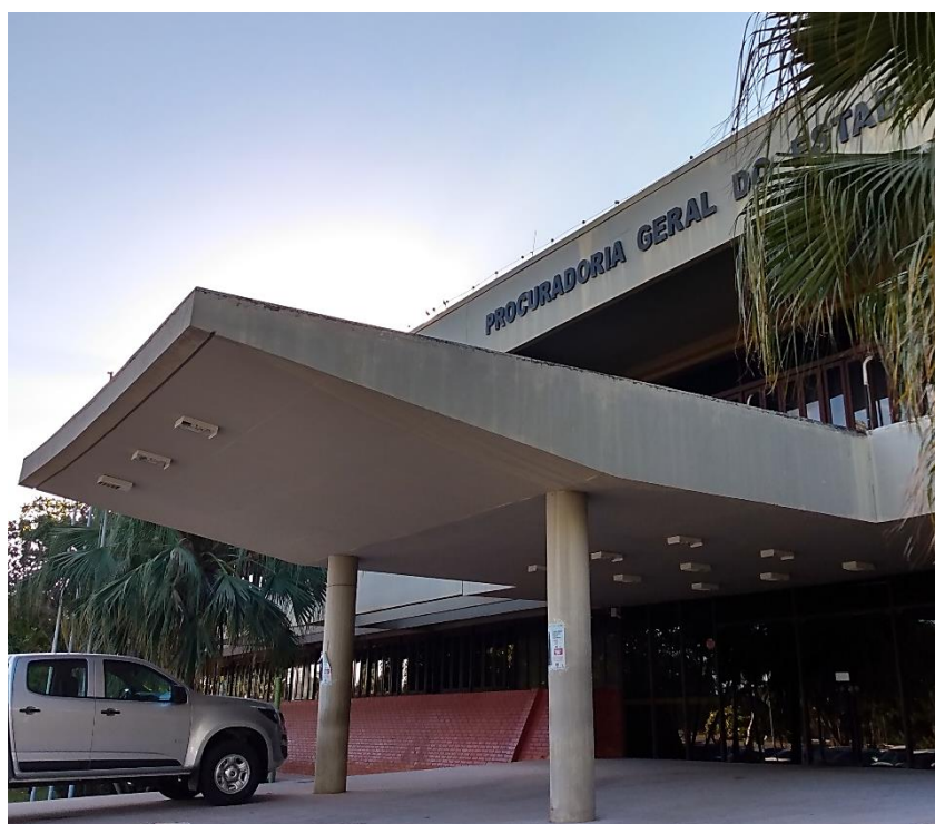
Figura 36 – Vista da marquise do edifício da Procuradoria Geral do Estado
