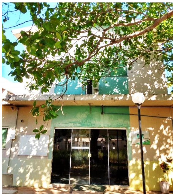
Figura 72 – Vista frontal do bloco DTE
