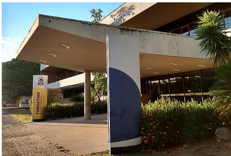
Figura 55 – Vista da marquise do edifício do Terratins
