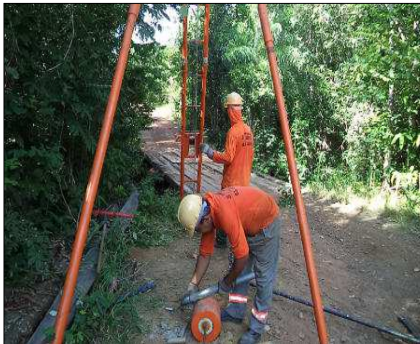
Fotografia 1 - Processo de execução do Ensaio SPT
