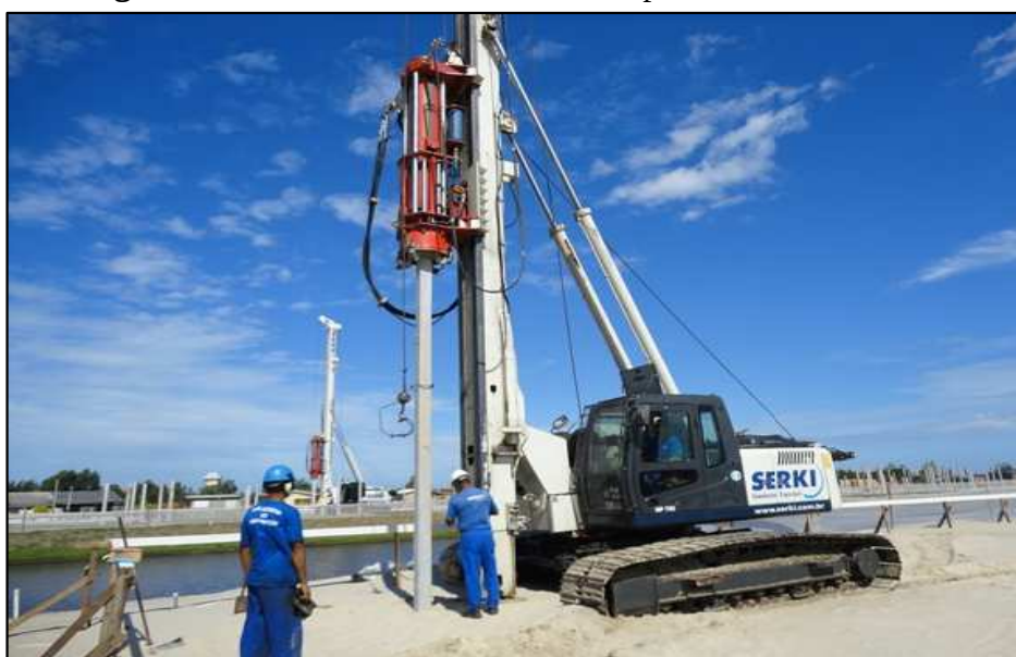
Fotografia 2 - Processo executivo estacas pré-moldadas de concreto
