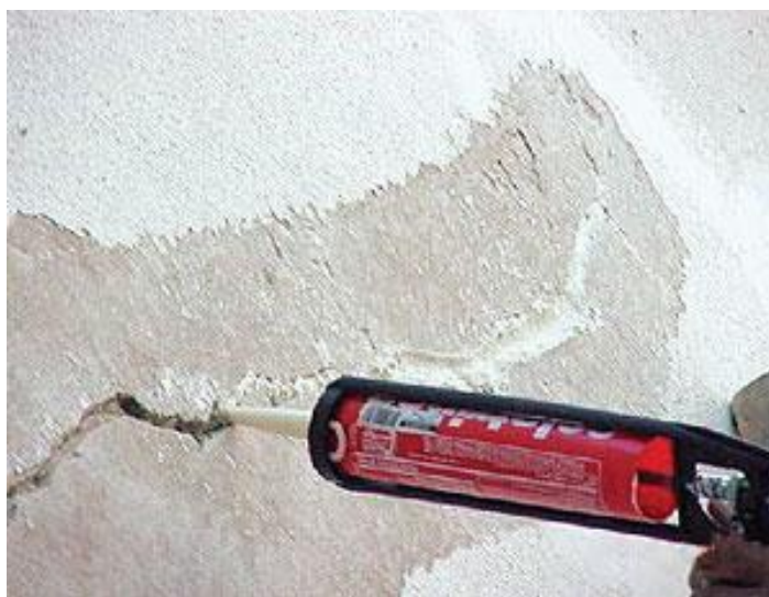
Figura 23 - Aplicação de selante plástico em trinca
