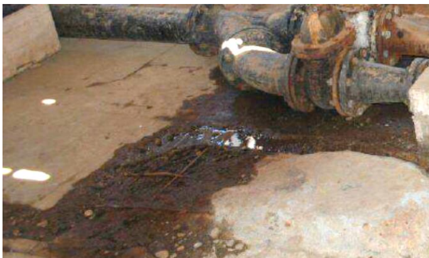
Figura 13 - Corrosão de armaduras próximo à base da bomba
