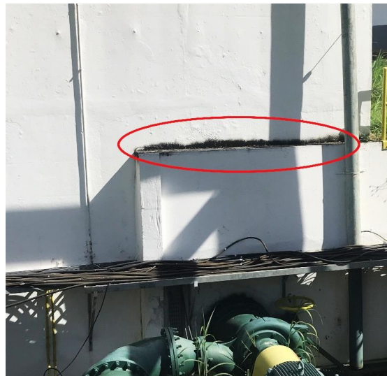
Presença de bolor/mofo nas paredes do tanque de contato (em destaque).
