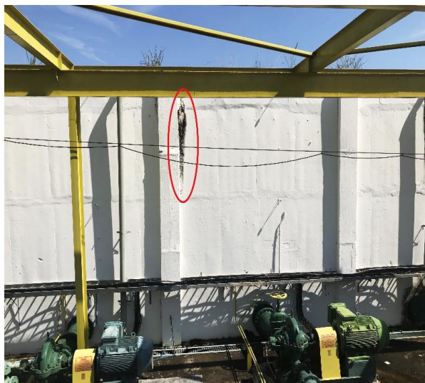
Presença de bolor/mofo nas paredes do tanque de contato (em destaque).
