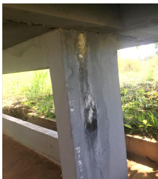
Pilares com manchas de umidade indicativas de falhas na impermeabilização, mofo/bolor e efflorescências.
