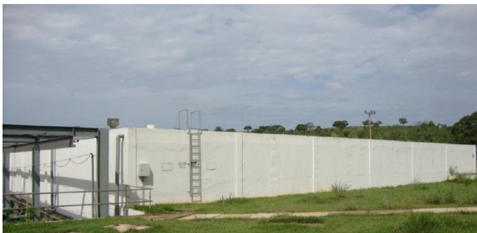
Figura 29 - Tanque de contato/Reservatório de compensação
