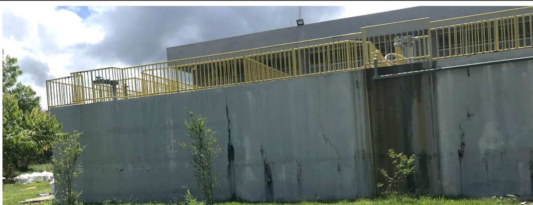
Parede externa dos filtros com presença eflorescências, fissuras e mofo/bolor.
