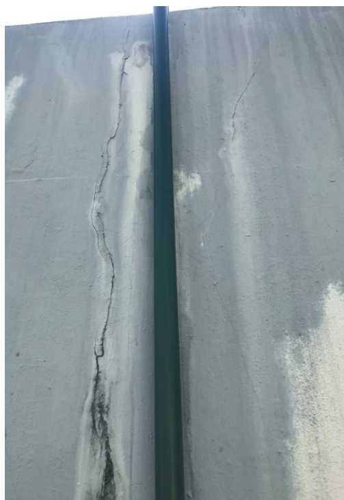
Fissuras provenientes da movimentação da estrutura, bolor/mofo e eflorescências na parede externa dos floculadores.
