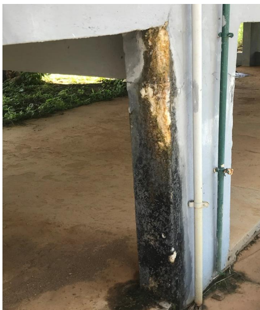
Pilares com manchas de umidade indicativas de falhas na impermeabilização, mofo/bolor e efflorescências.
