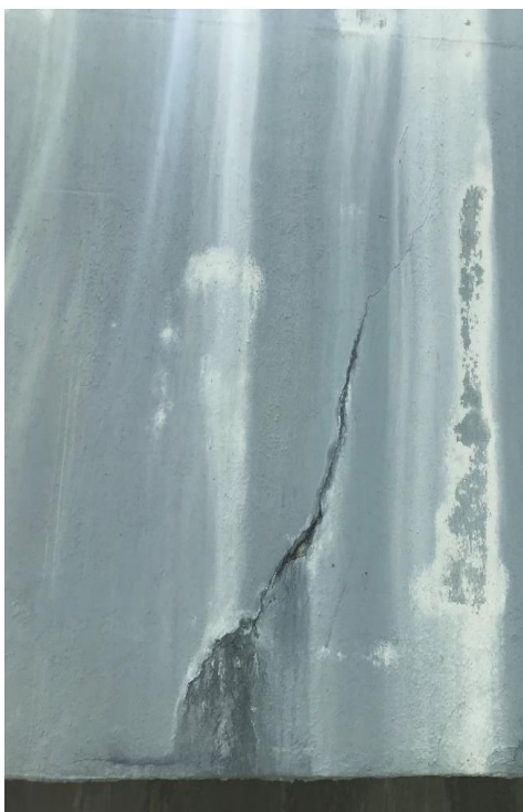
Fissuras provenientes da movimentação da estrutura, bolor/mofo e eflorescências na parede externa dos floculadores.
