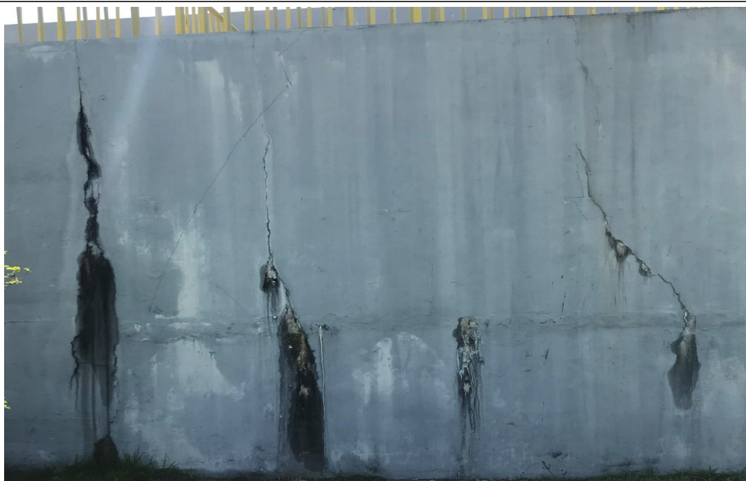
Parede externa dos filtros com presença eflorescências, fissuras e mofo/bolor.
