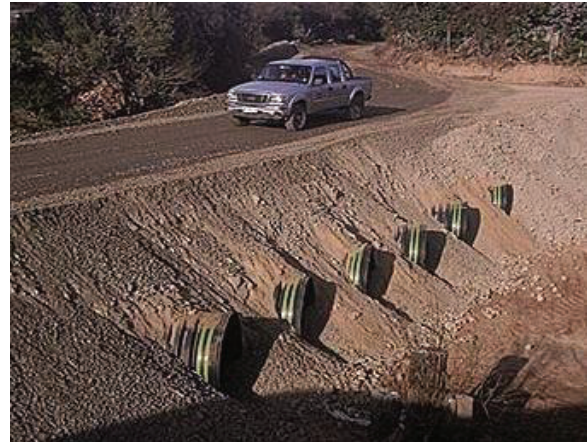
Figura 4 - Drenagem Subterrânea de Rodovia - Dreno Transversal
