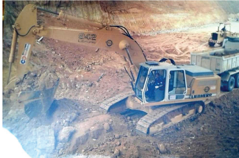
Figura 2 - Escavação com escavadeira
