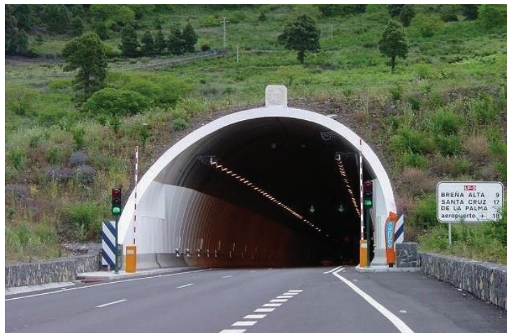
Figura 17 - Túnel em Rodovia de Pista Simples
