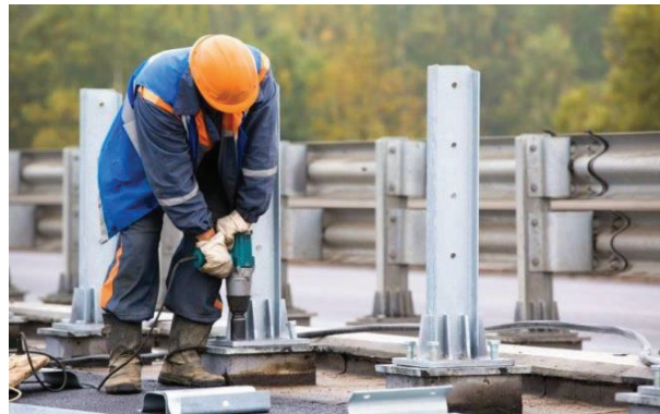
Figura 14 - Instalação de Barreira Flexível
