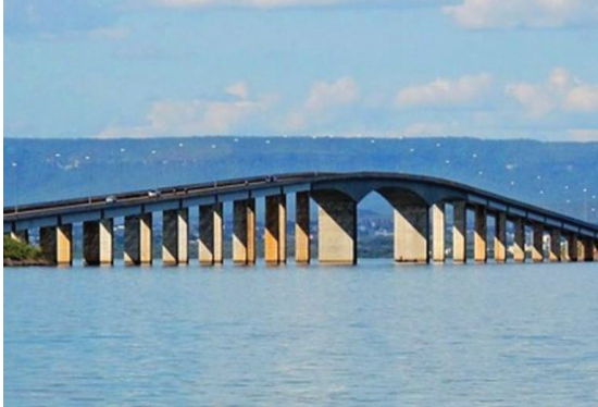
Figura 15 - Ponte Fernando Henrique Cardoso em Palmas - TO
