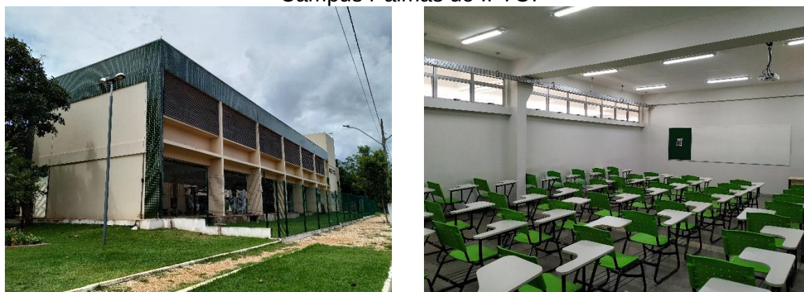
Figura 3 – Vista interna das salas de aula e vista externa dos blocos 14 a 17 do Campus Palmas do IFTO.
