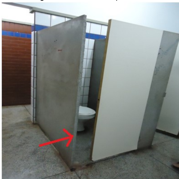
Figura 08 – Divisória quebrada
