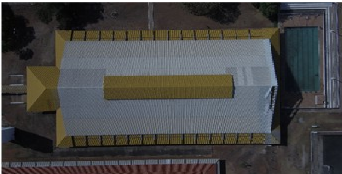
Figura 6 – Inspeção à cobertura do ginásio utilizando drone
