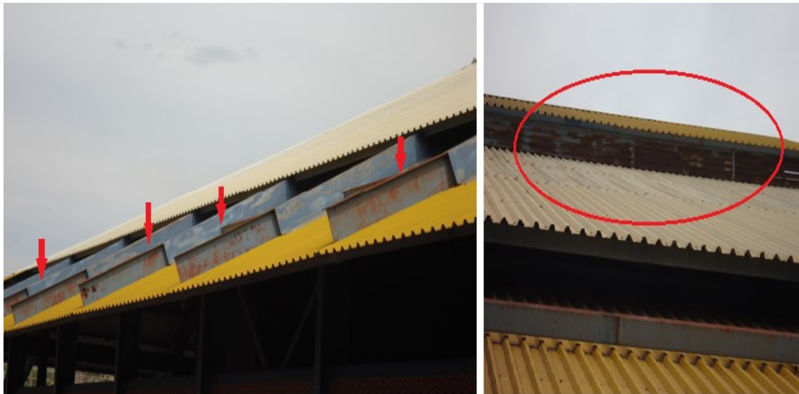
Figura 43 – Corrosão
