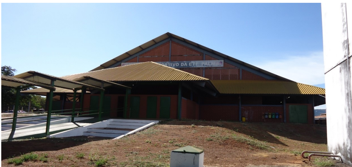
Figura 5 - Fachada do ginásio
