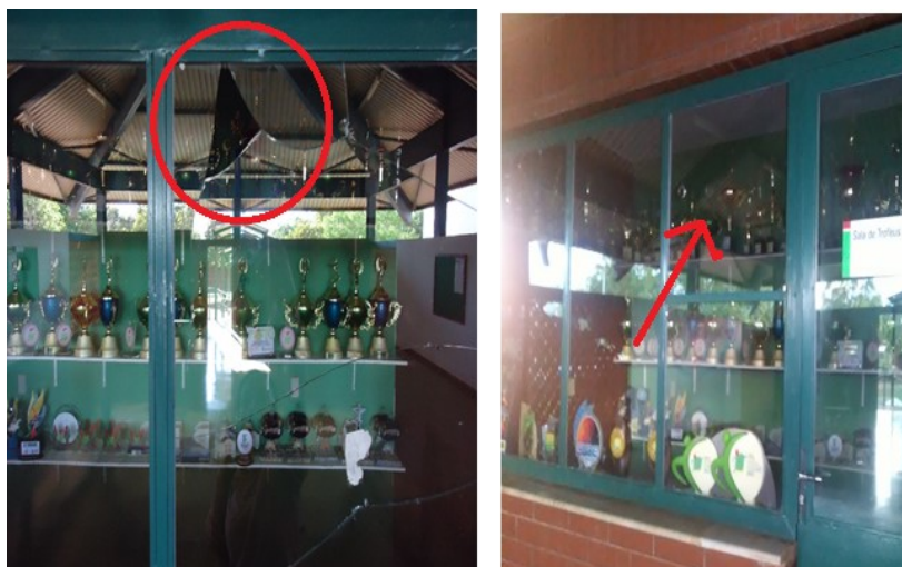
Figura 9 – Serviço de manutenção realizado na porta de vidro da sala de Troféus
