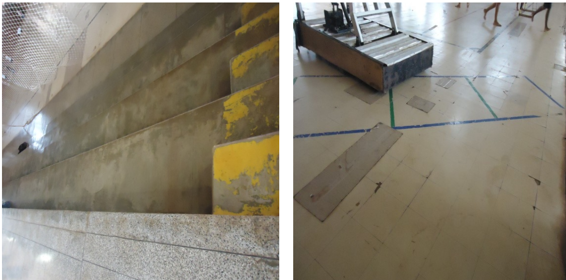
Figura 16 – Desgaste dos pisos
