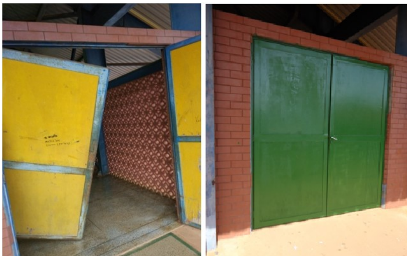
Figura 8 - Serviço de manutenção realizado nas portas externas
