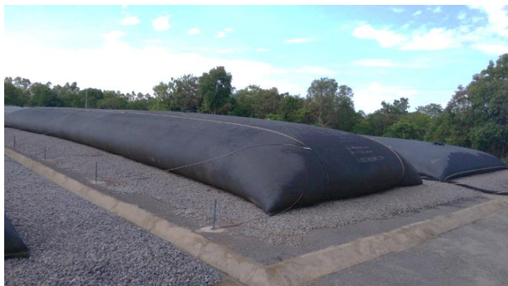
Figura 9 – Bags no pátio da ETE Norte (2016)
