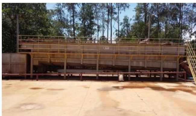
Figura 7 - Flotador da ETE Prata Fonte: Palmas (2017).
