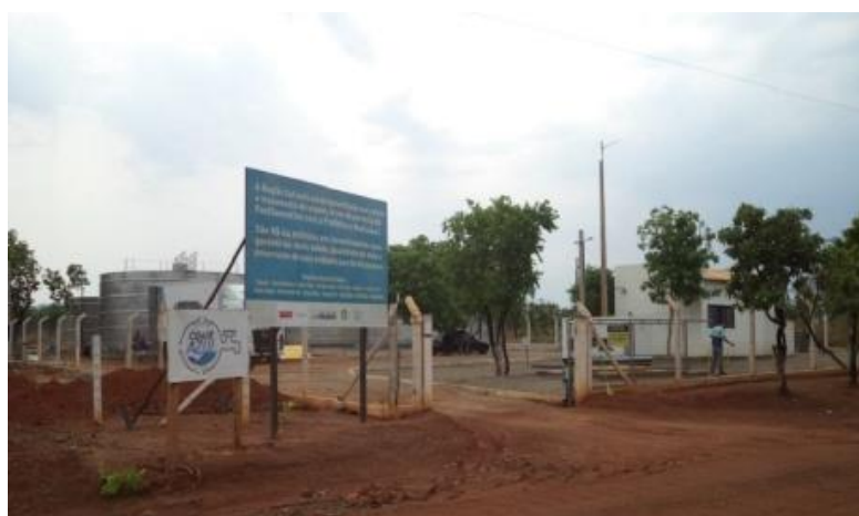
Figura 10 - ETE Santa Fé
