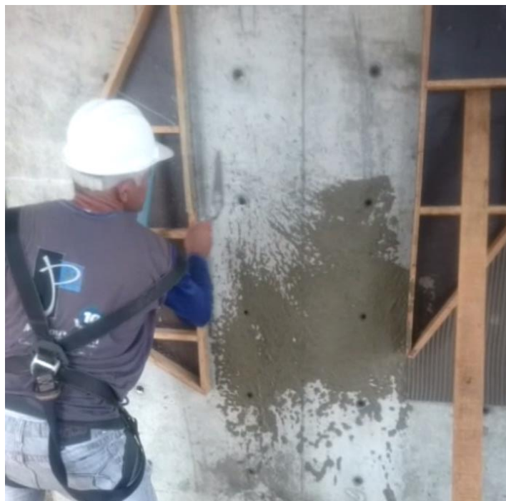
Figura 20 - Aplicação de chapisco com aditivo colante com colher de pedreiro, mesma forma de aplicação do chapisco convencional
