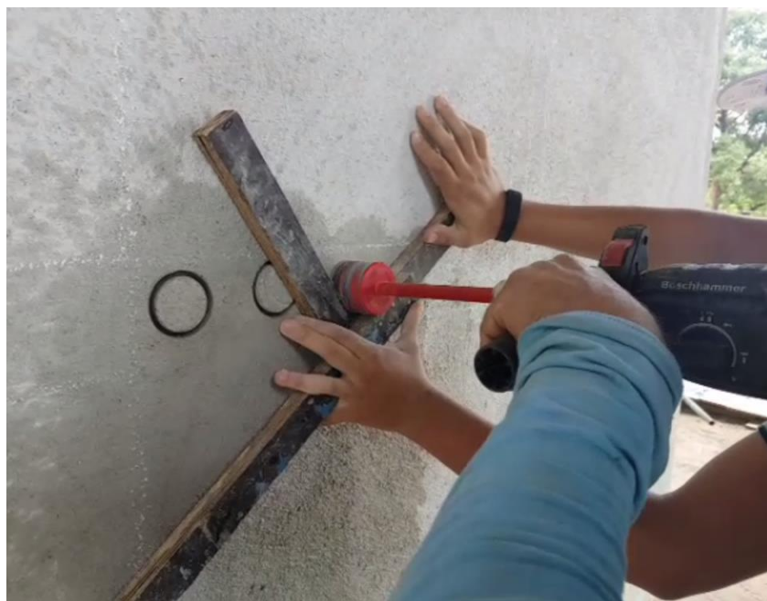
Figura 24 - Execução dos furos, utilizando apoio de madeira para a serra copo
