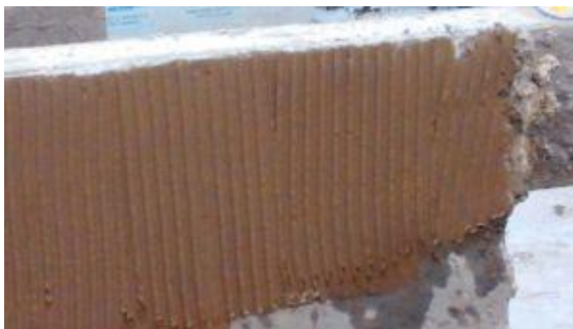
Figura 2 - textura do chapisco industrializado aplicado com desempenadeira
