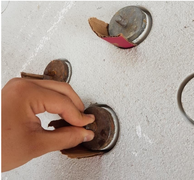
Figura 26 - Colagem das pastilhas metálicas
