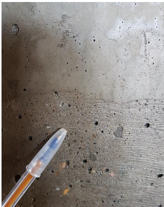
Figura 19 - Contraste entre superfície não lixada (a cima) e lixada (a baixo)
