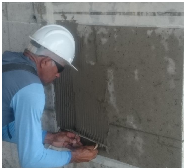
Figura 21 - Aplicação de argamassa industrializada, utilizada como chapisco
