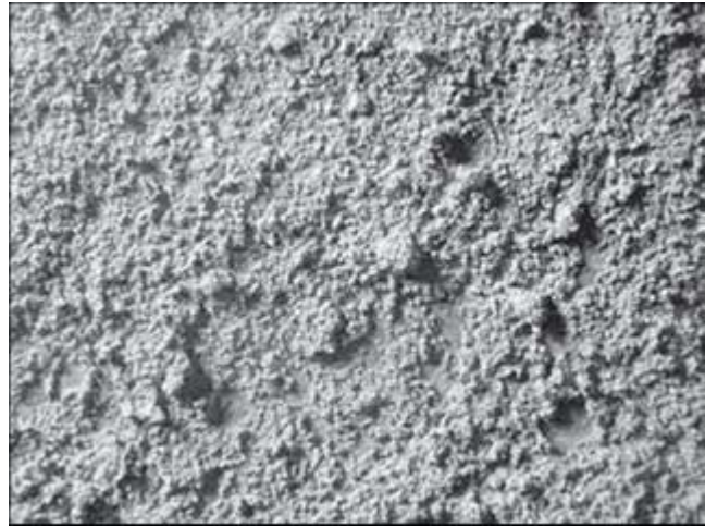
Figura 1 - textura do chapisco convencional
