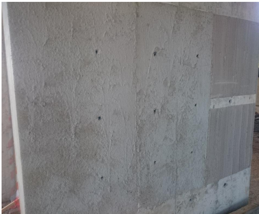
Figura 22 - Acabamento do chapisco com argamassa industrializada
