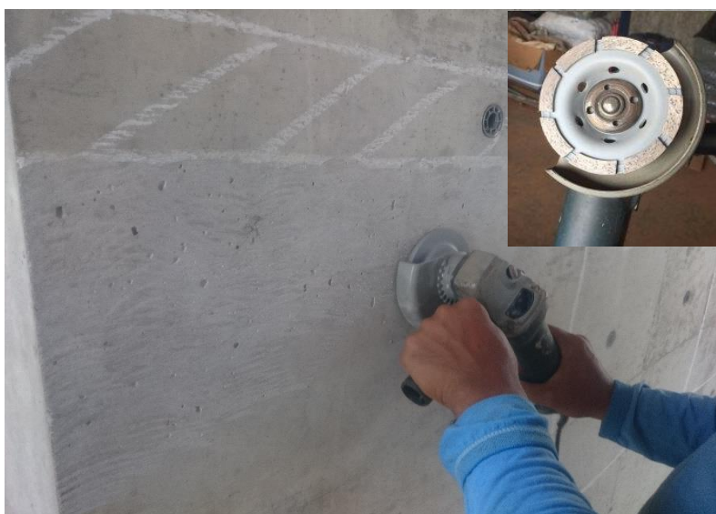
Figura 18 – Execução do lixamento, no detalhe, o disco
