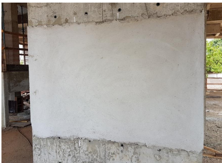
Figura 23 - Acabamento do revestimento argamassado no pilar 1 (chapisco curado)
