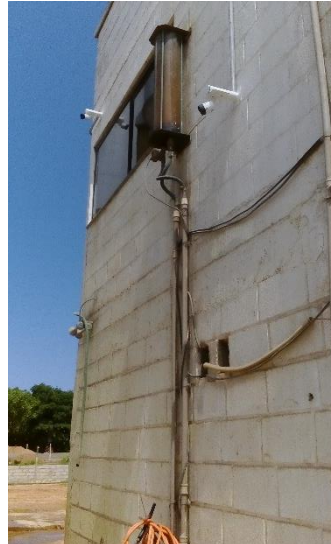
Figura 17 – Dosador volumétrico do aditivo
