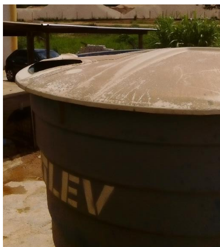
Figura 15 – Armazenamento inadequado da água utilizada na dosagem
