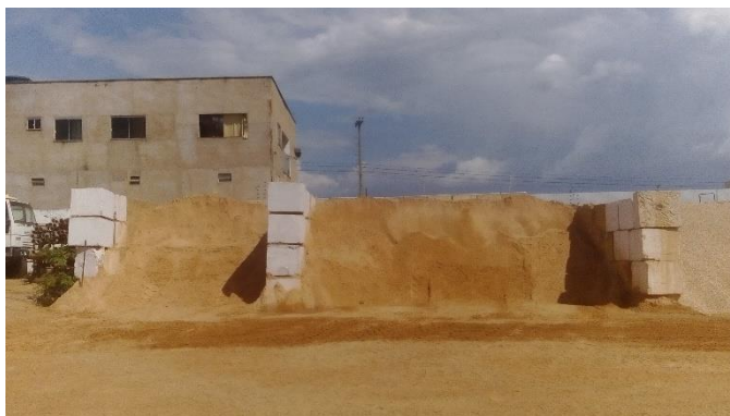
Figura 9 – Armazenamento adequado dos agregados
