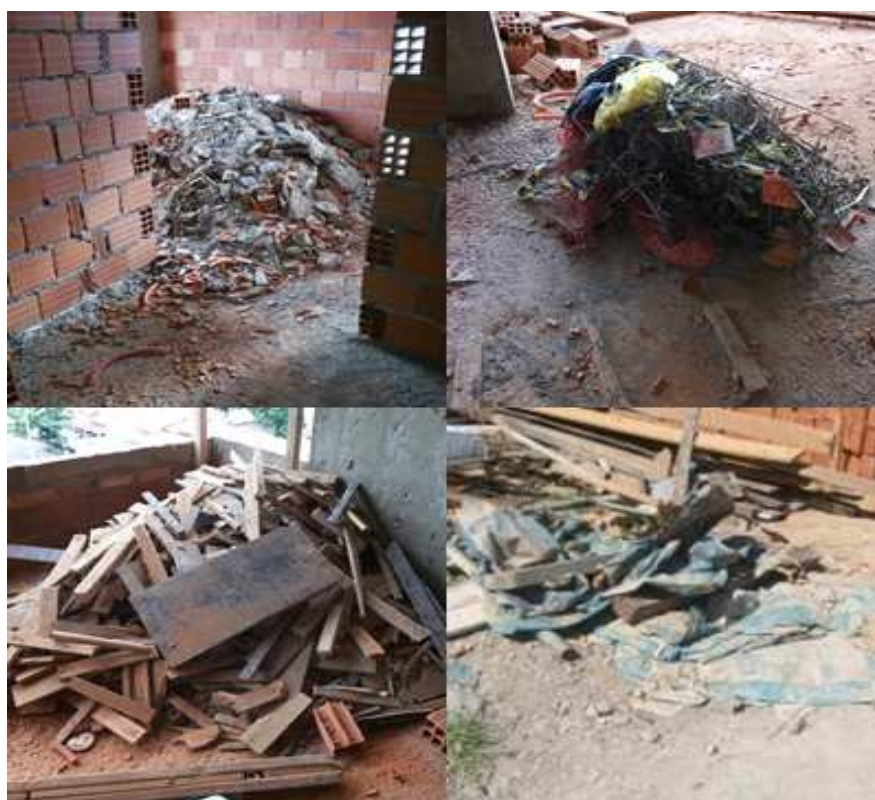
Figura 01: Resíduos da Obra
