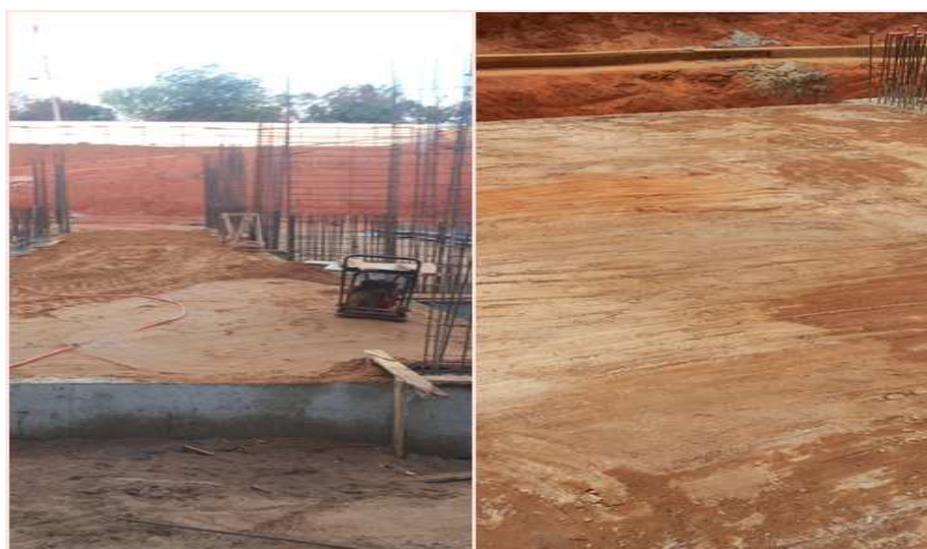
Figura 7: Adensamento hidráulico à esquerda, solo cimento à direita.
