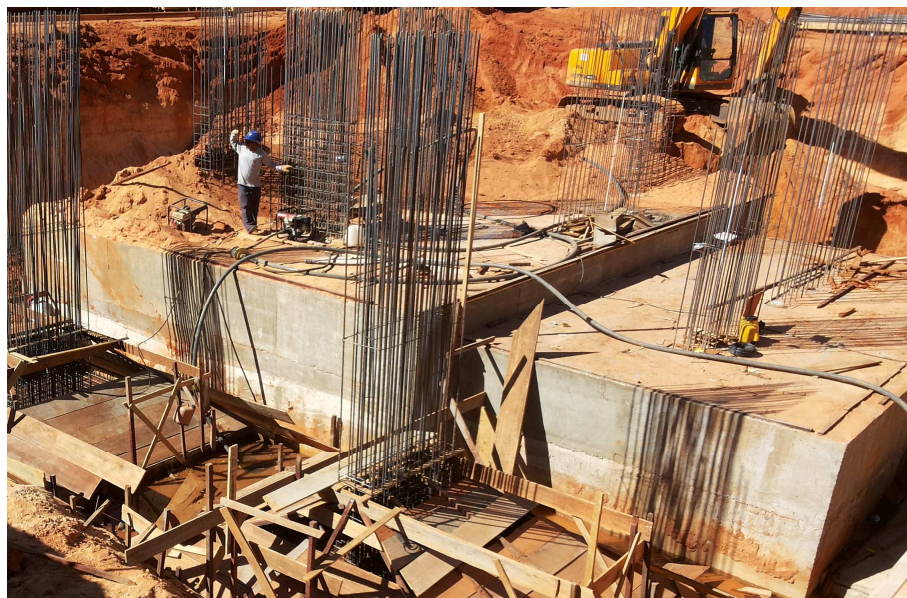
Figura 6: Sapatas associadas.
