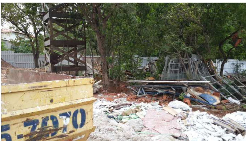
Foto1 - Armazenamento inadequado dos entulhos - Empresa A
