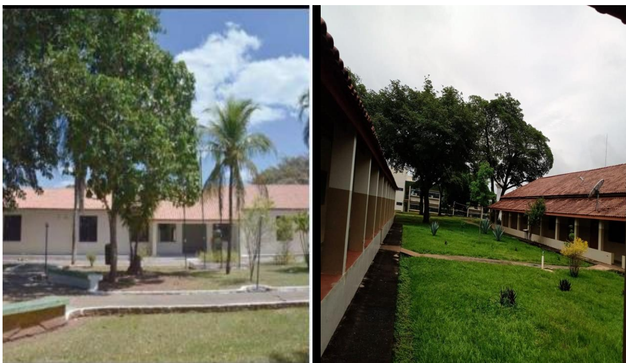
Figura 163. Infraestrutura externa e áreas de lazer do Campus (conservação, iluminação, paisagismo e limpeza).
