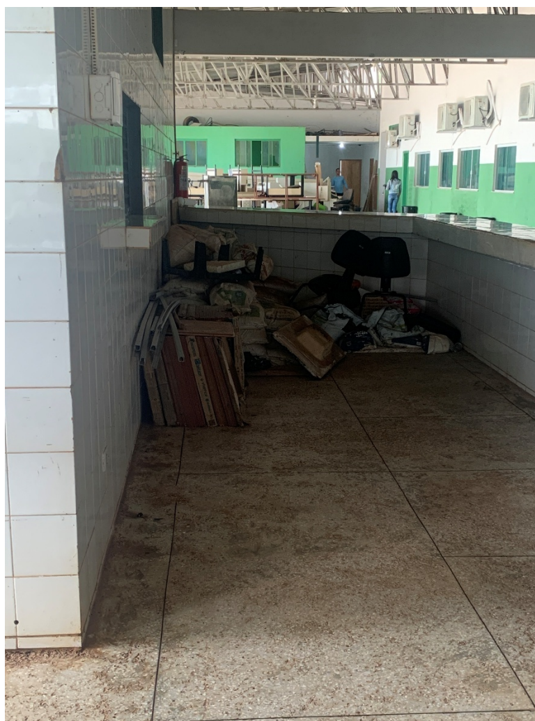
Figura 2 – Cantina do Campus Avançado Formoso do Araguaia
