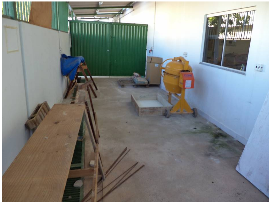
Figura 19: Laboratório de canteiro de obras Fonte: próprios autores.
