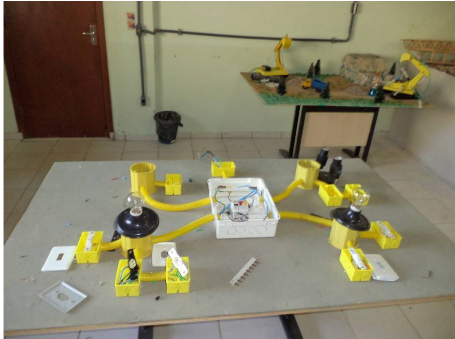
Figura 21: Laboratório de Prática de Instalações Prediais: instalações elétricas. Fonte: próprios autores
