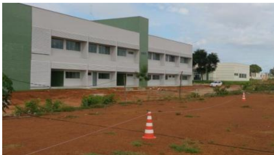
Figura 3- Prédio Administrativo das Novas Instalações em agosto /2015
