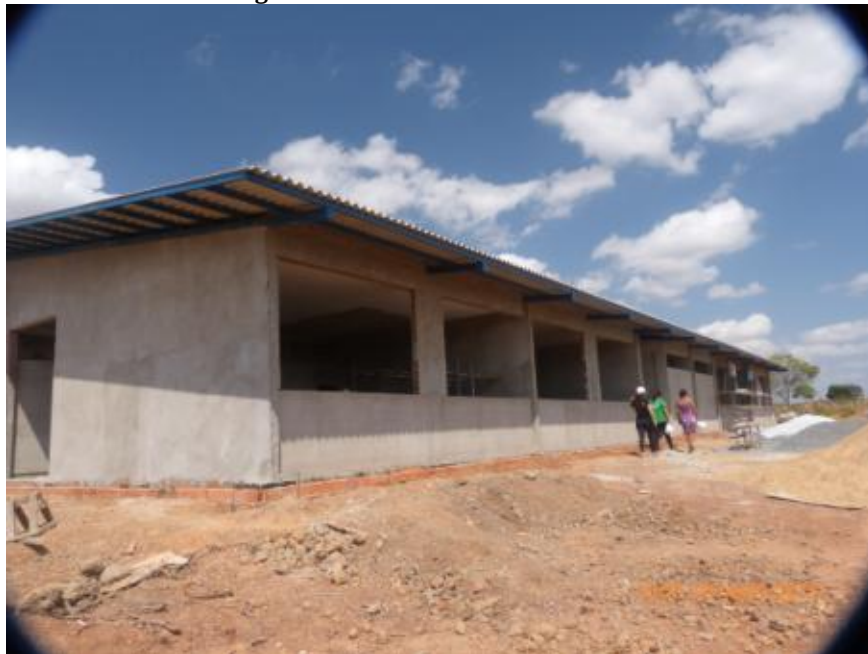
Figura 7 - Bloco com 9 Salas de Aulas em Construção em agosto /2015
