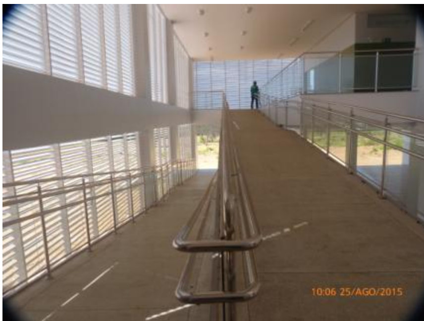
Figura 14 - rampa de acessibilidade no prédio administrativo em agosto /2015
