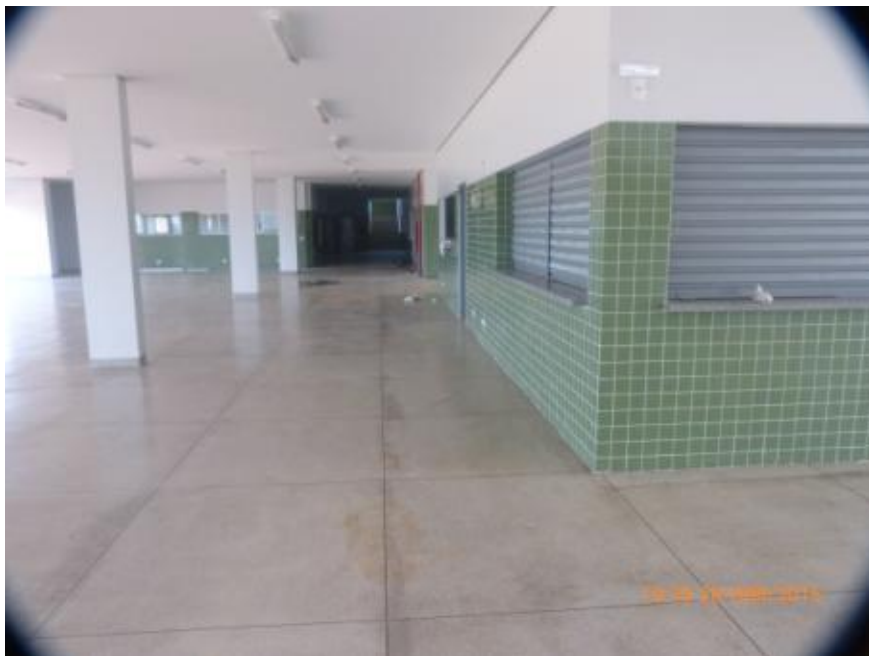
Figura 4- Hall do Prédio Administrativo das Novas Instalações em agosto /2015
