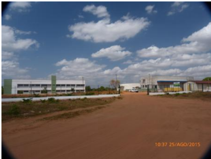
Figura 2- Novas Instalações do IFTO Campus Colinas do Tocantins em agosto /2015
