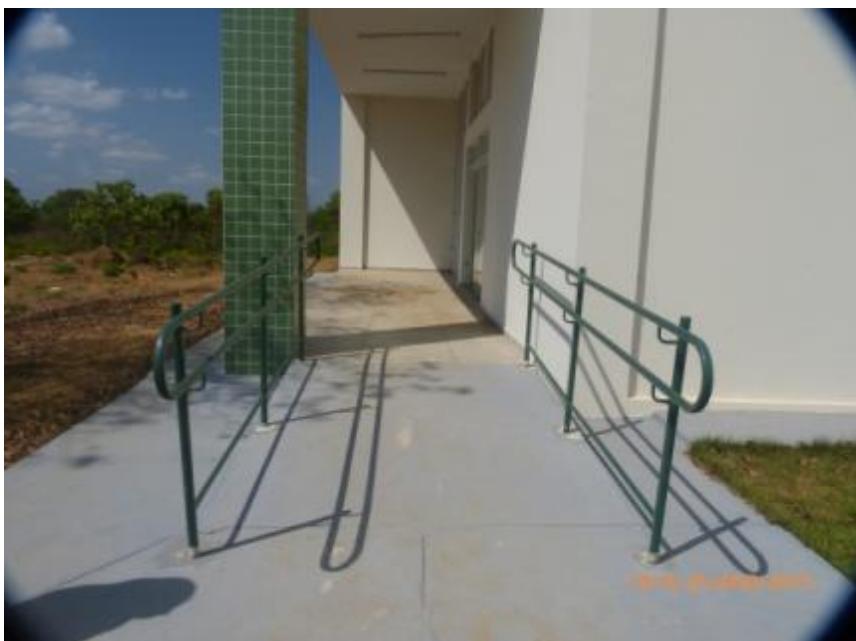
Figura 15 - rampa de acessibilidade na biblioteca em agosto /2015
