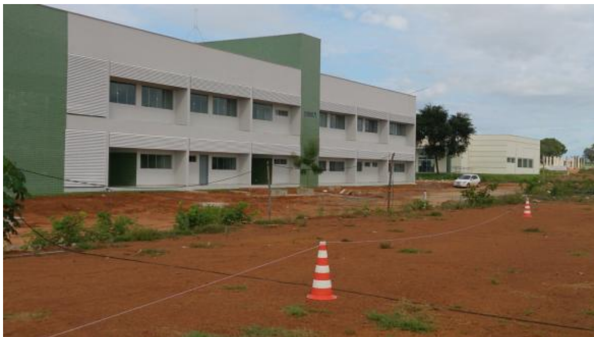
Figura 5 - Prédio Administrativo das novas Instalações
