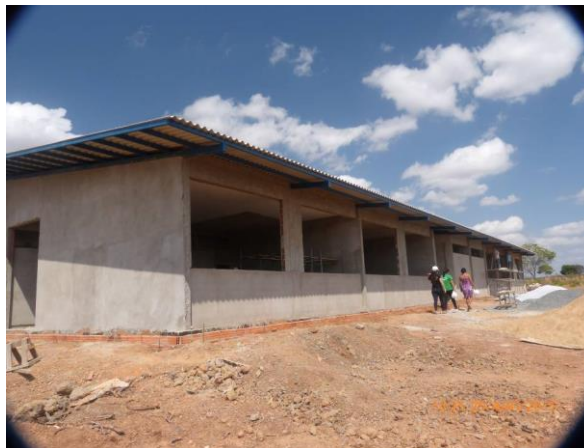
Figura 11 - Auditório Central - lado externo em agosto /2015
