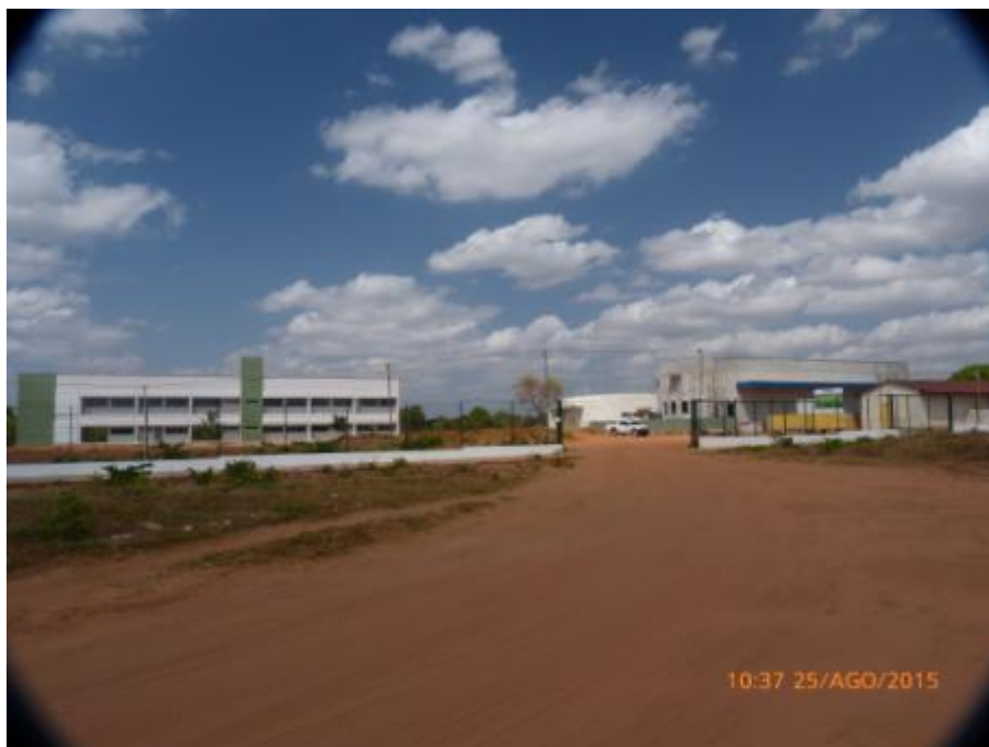
Figura 2 - Novas Instalações do IFTO Câmpus Colinas do Tocantins em agosto /2015
