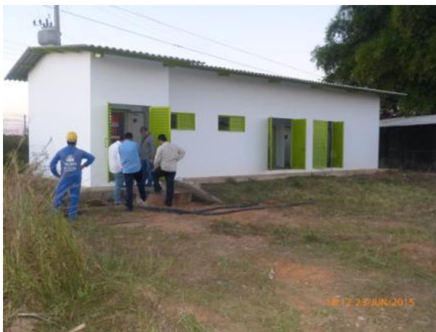
Figura 5 - Subestação de Energia Elétrica em agosto /2015
