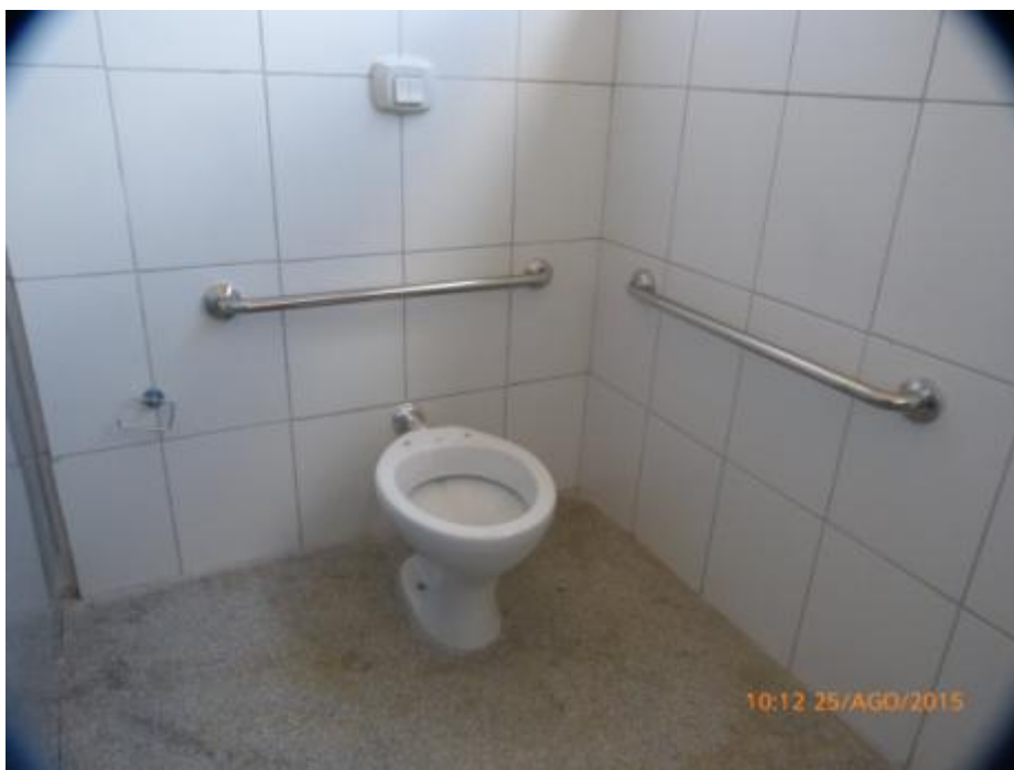
Figura 17 - sanitários para pessoas com deficiência ou mobilidade reduzida em agosto /2015
