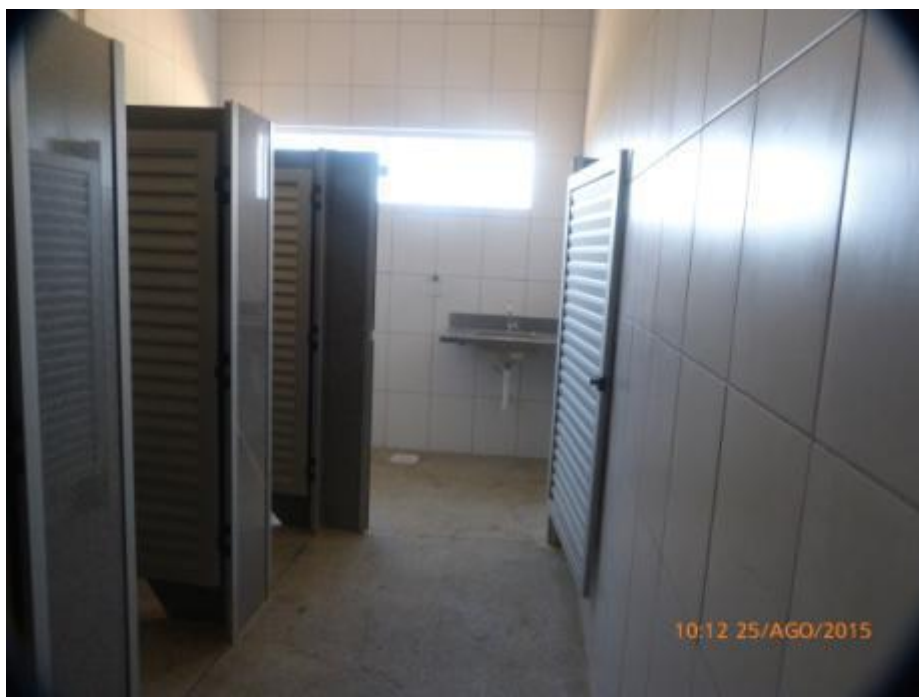
Figura 16 - banheiros com acessibilidade para pessoas com deficiência ou mobilidade reduzida em agosto /2015
