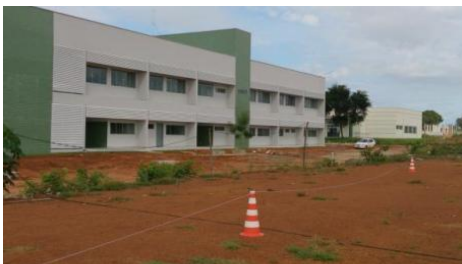
Figura 3 - Prédio Administrativo das Novas Instalações em agosto /2015
