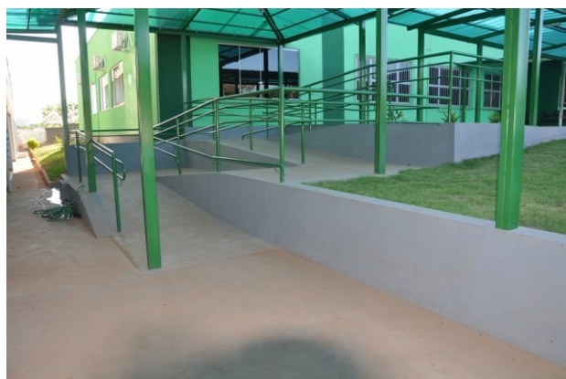
FIGURA 2 - Rampas de acessibilidade
