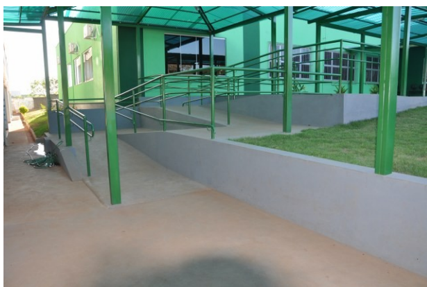
FIGURA 2 - Rampas de acessibilidade
