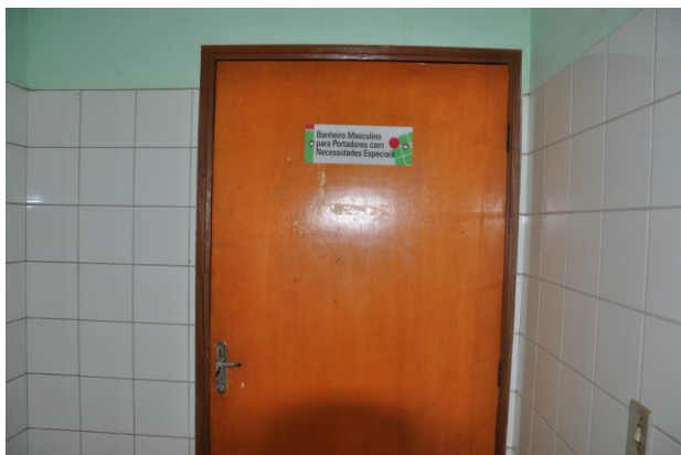
FIGURA 3 – Sanitários com acessibilidade
