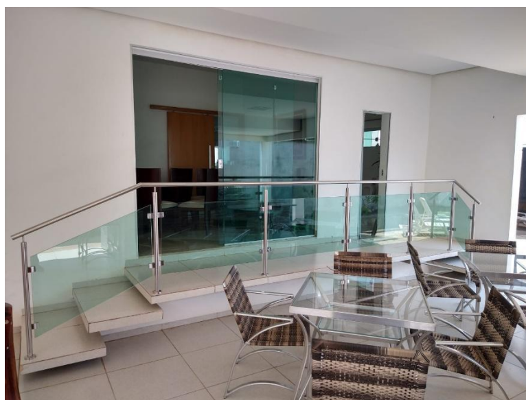
Figura 02. Vidro Temperado aplicado na porta e no guarda-corpo.
