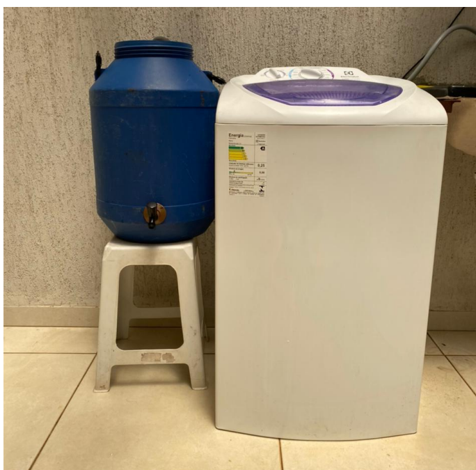
Figura 2 — Minicisterna posicionada para receber a água da máquina de lavar
