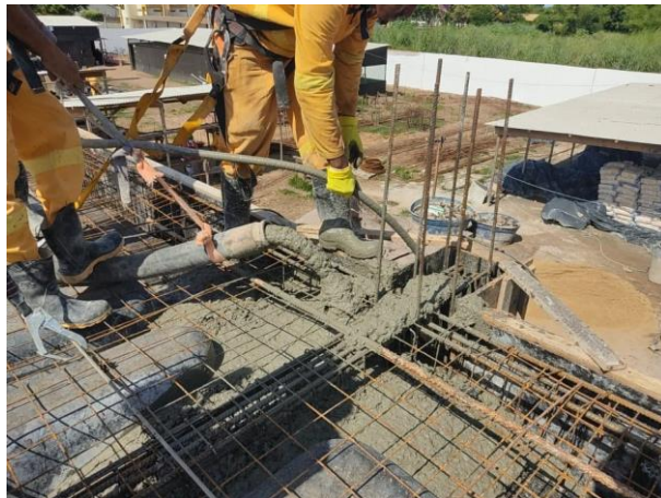
Figura 13 – Concretagem em altura.
