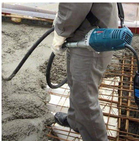
Figura 05 – Vibrador de concreto.
