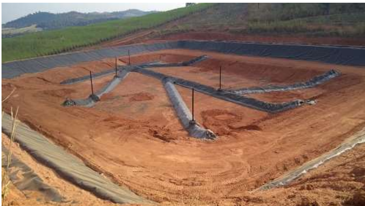
Figura 8 - Sistema drenagem espinha de peixe
