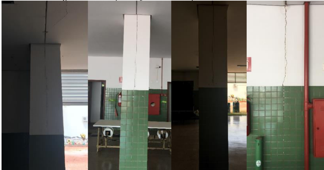
Figura 15 – Situação das juntas de dilatação do térreo do bloco V
