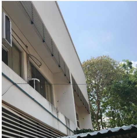
Figura 12 – Platibanda com pingadeira
