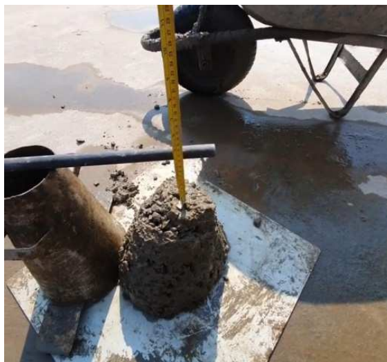
Figura 18 - Verificação do abatimento
