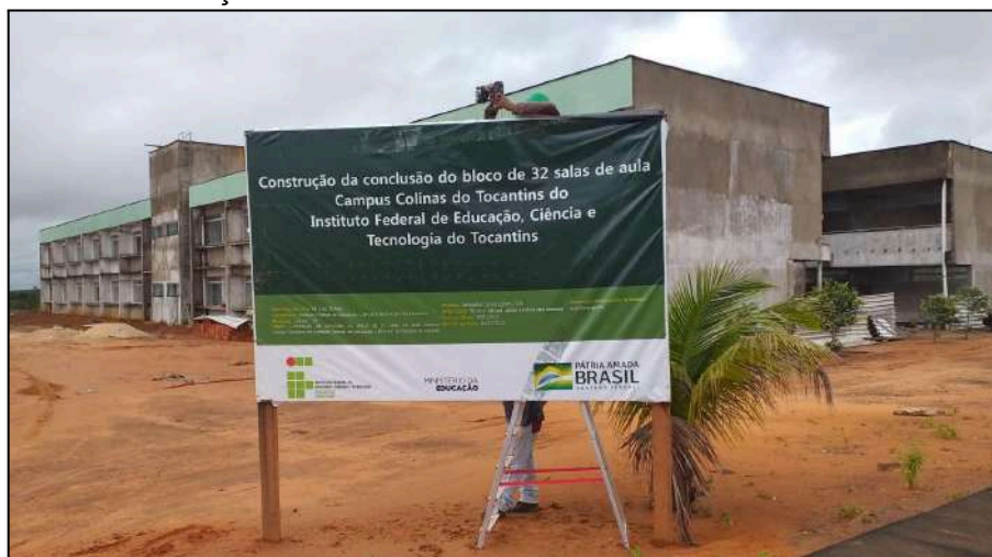
Imagem 4 - Início da construção do Bloco Canarinho - atual bloco de salas de aula
