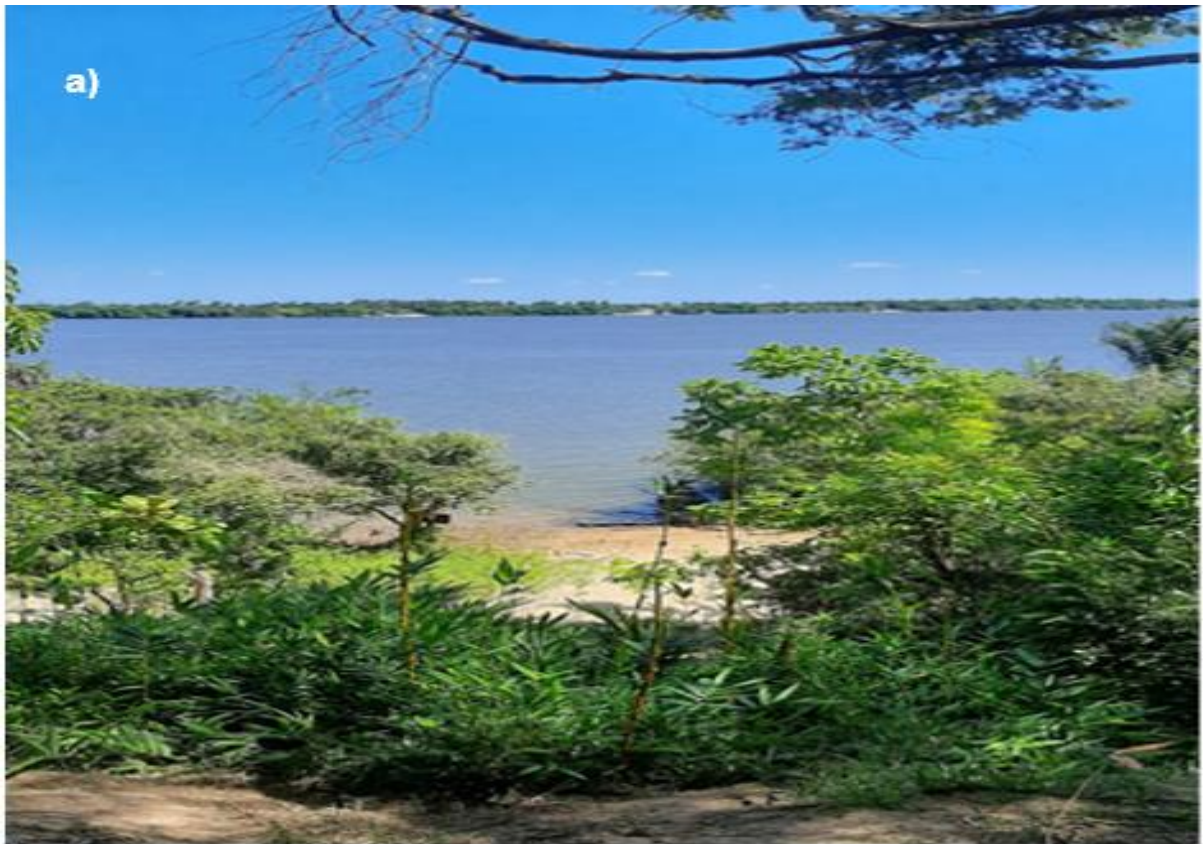
Figura 12: Tentativa de conter a erosão
