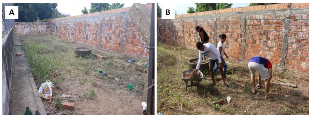
Figura 3 - Pré-construção da horta. (A) Local da horta. (B) Limpeza do local.
