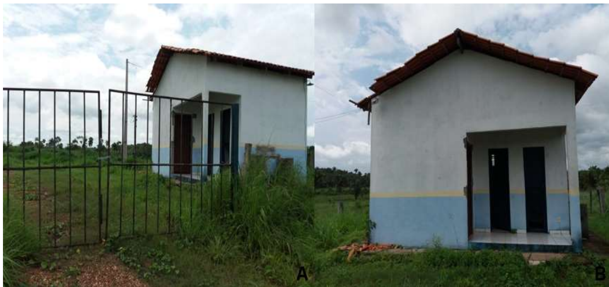
Figura 15 - Situação atual da guarita e entrada do aterro sanitário da cidade de Augustinópolis - TO. A e B, guarita e entrada.
