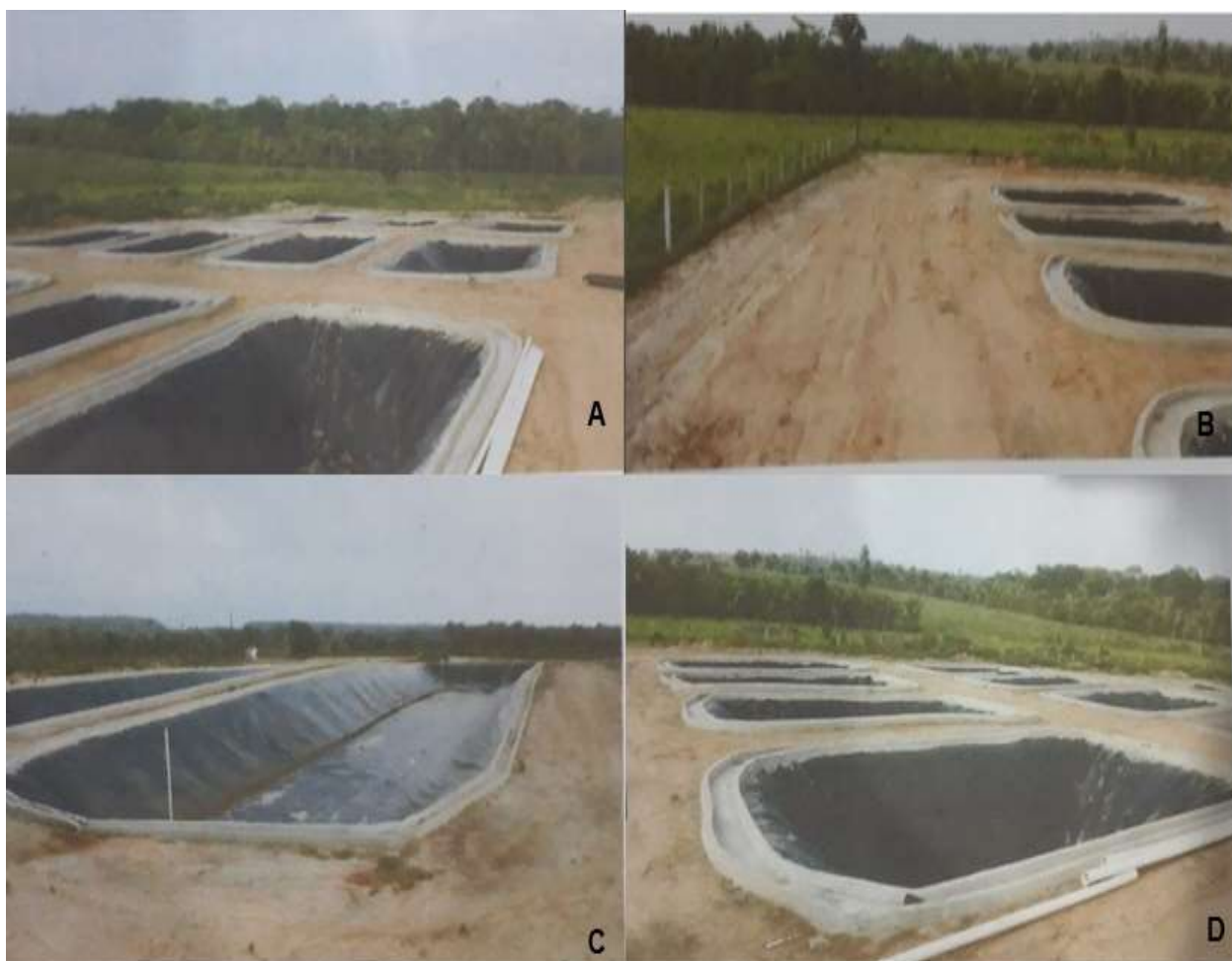
Figura 11 - Aterro sanitário concluído em 29/11/2016 da cidade de Augustinópolis -TO.
