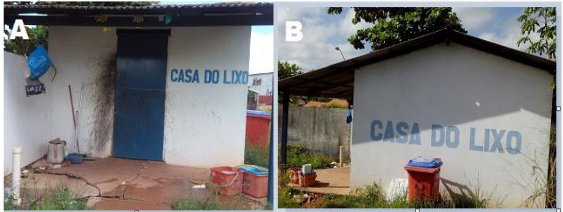
Figura 10: Abrigo externo ou Casa do Lixo; A Vista de frente; B vista lateral.
