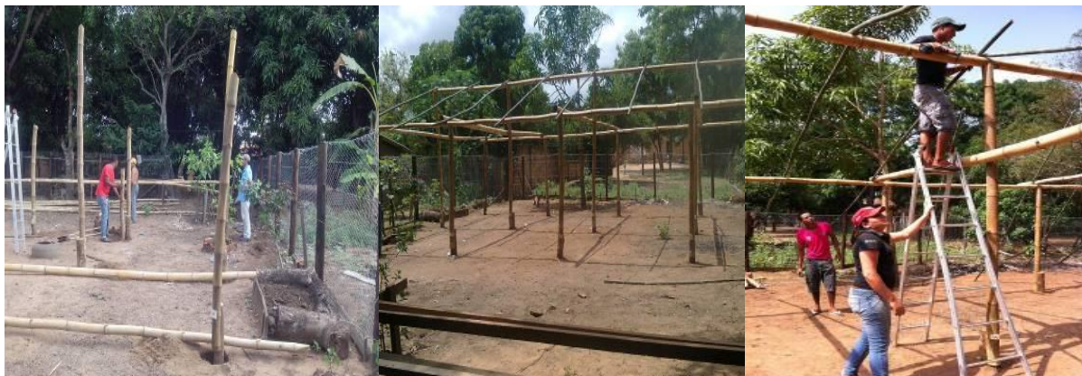
Figura 5 - Etapas de construção da estufa
