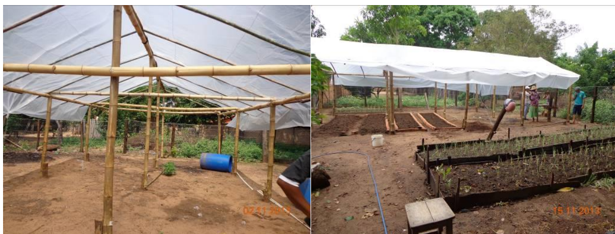
Figura 7 - Estufa concluída e construção dos canteiros dentro da estrutura.
