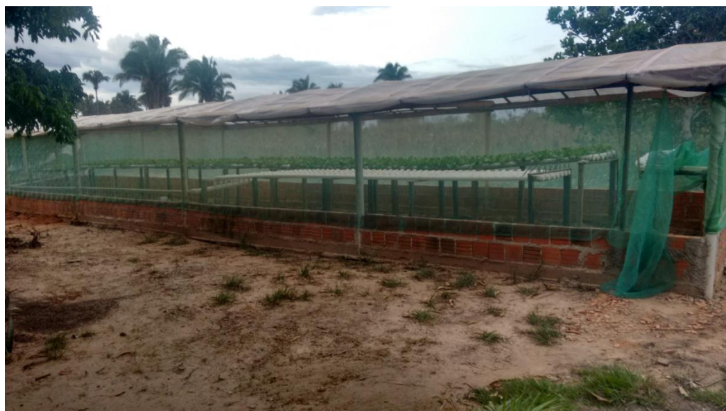
Figura 08 – Estrutura da casa de vegetação
