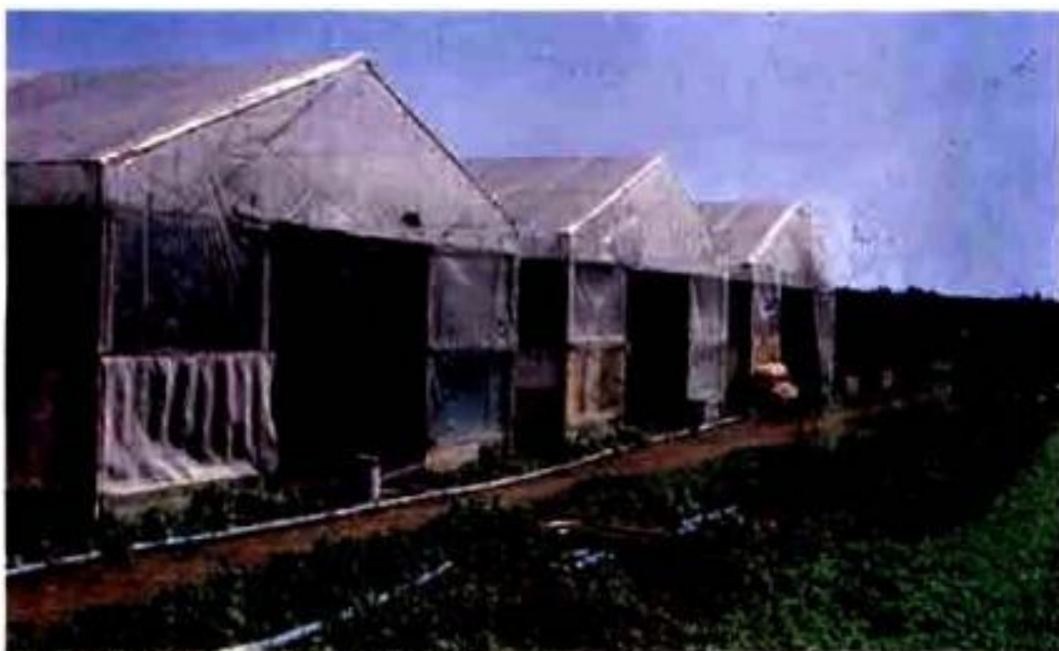
Figura 02 – Modelo de Estrutura em capela.
